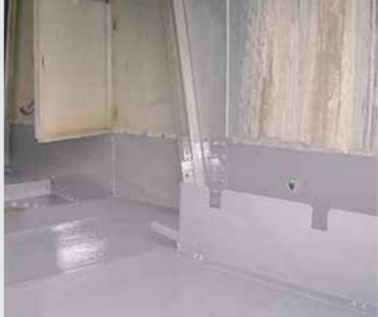
Oprava a ochrana systému kondenzácie vody
