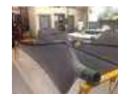
Oprava a ochrana lopatiek ventilátora
